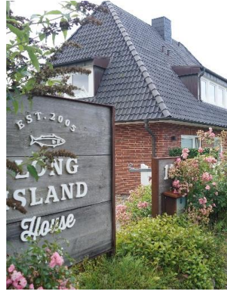
Abbildung 55: Long Island House in Westerland Süd
