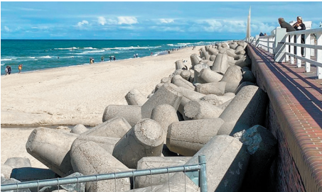
Die zum Teil gebrochenen Tetrapoden vor der dem Altbestand der Uferwand werden 2022 abtransportiert.
