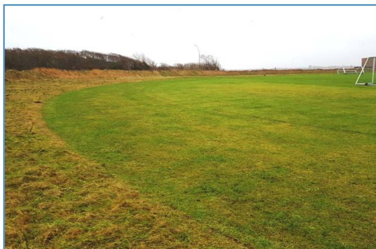
Rundlaufbahn / Spielfeld - Tennenfläche Rundlaufbahn nahezu vollständiger Grasbewuchs
