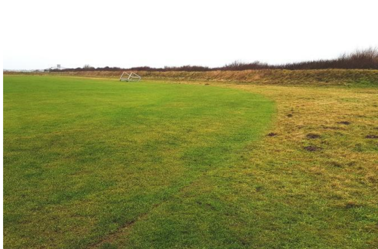
Rundlaufbahn / Spielfeld - Tennenfläche Rundlaufbahn nahezu vollständiger Grasbewuchs
